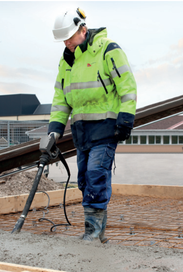
Rüsten Sie Ihren Rüttler mit längerem Schlauch und/oder Elastomer-Endkappen aus.
